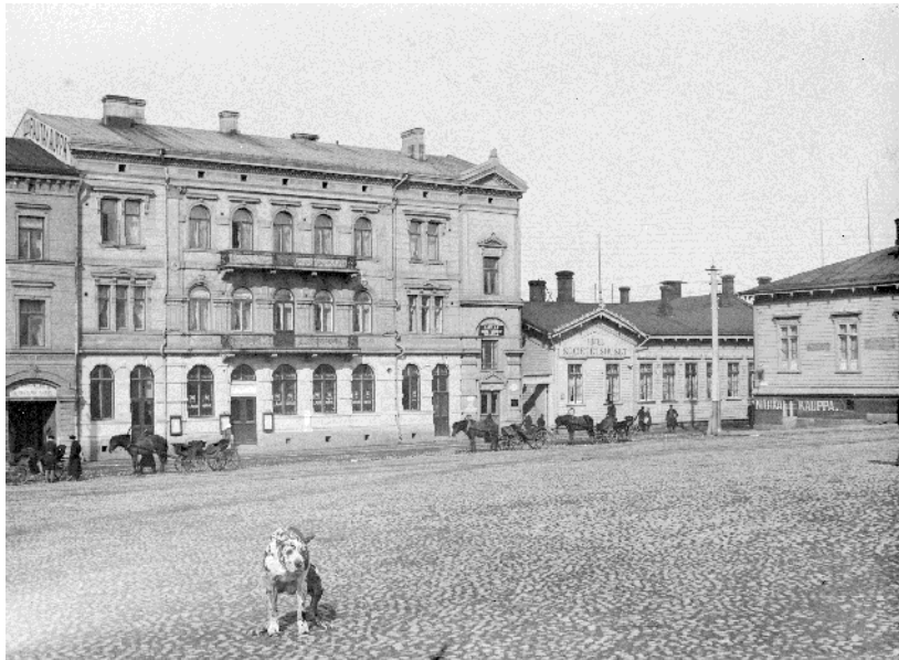
Sandbergin talon kolmas 1897 valmistunut Aleksis Kiven kadun varren rakennusosa idästä. Kuva: Tampereen museoiden kuva-arkisto 1907 – 09.
