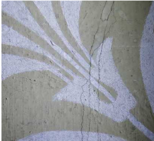
Peilikentän ornamentin maalausjälki kertoo, että kuvio on tehty osin sablonilla tuputtamalla, osin vapaalla kädellä siveltimellä. MH
