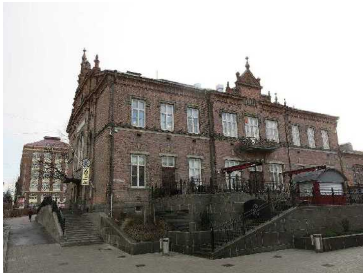
Tampereen tullikamari luoteesta. Käynti maalauksin koristeltuun pääportaaseen on vasemmalta, rakennuksen pohjoispäädystä. Kuva: Miia Hinnerichsen, Pirkanmaan maakuntamuseo 2014.
